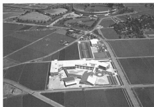
写真3 敷地は900坪の田んぼが4枚分。写真上は上のスタジアム寄りの病院棟と手前(写真下方)の通所リハビリ棟とは長短2本の廊下でつながっている
